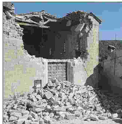
Accumoli distrutta dal sisma
